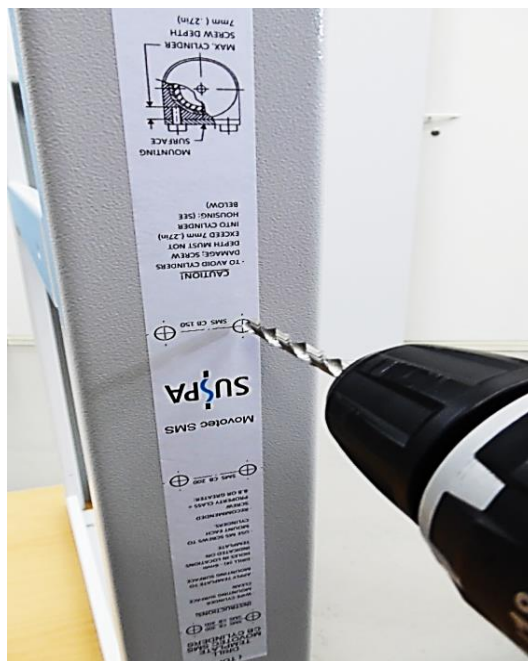
Abbildung 8 Bohren der Löcher
