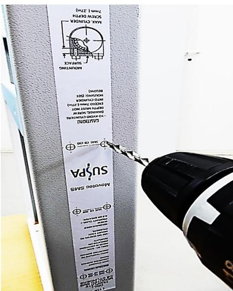
Abbildung 8 Bohren der Löcher
