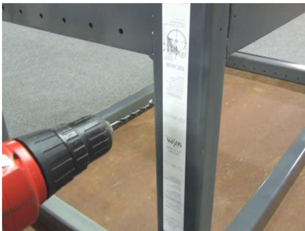
Abbildung 7 Bohren der Löcher
